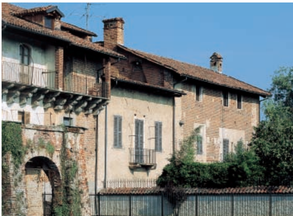
Castello Vialardi di Verrone, lato sud, edifici di impianto medievale
